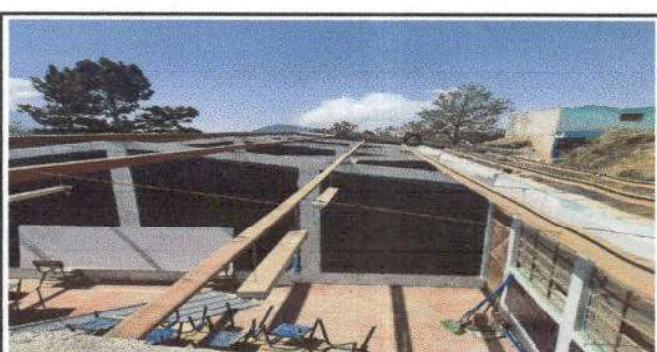
Foto 6: Sustitución de láminas troquelada aluzinc calibre 26
